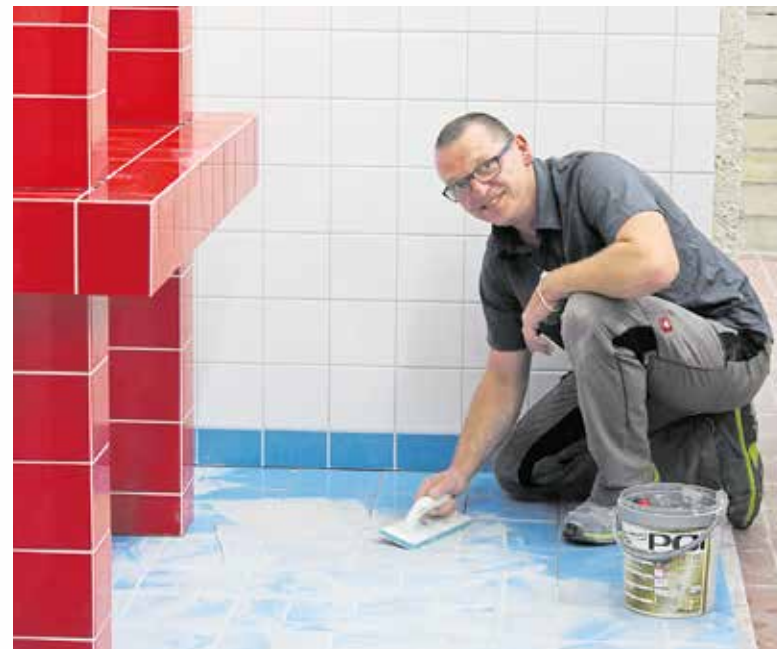
Jörg Uhlig beim abschließenden Verfugen seiner Meisterprüfungsarbeit.
